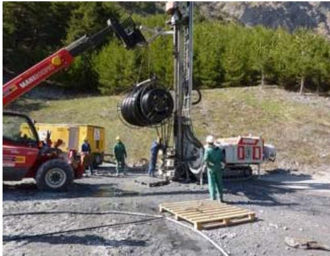
Impianto GCHP con 30 sonde doppio tubo a U con fluido termovettore acqua
