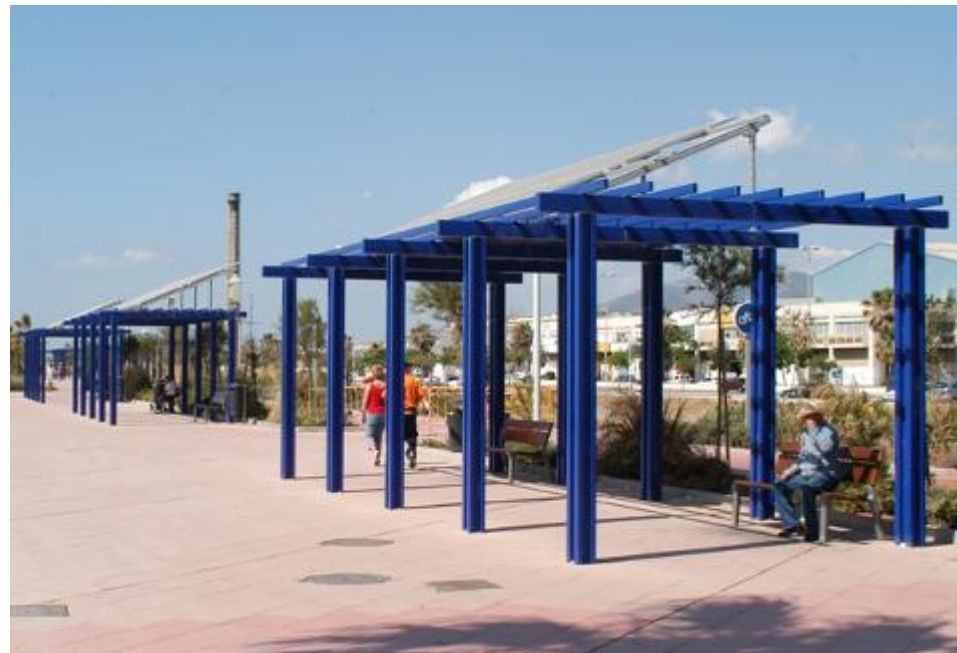
Tettoie con celle fotovoltaiche
