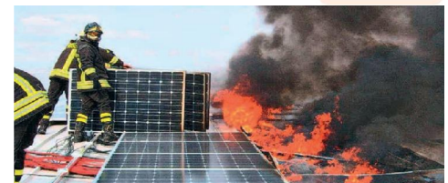
Intervento dei VV.F su un impianto FV
