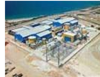
Impianto di desalinizzazione
