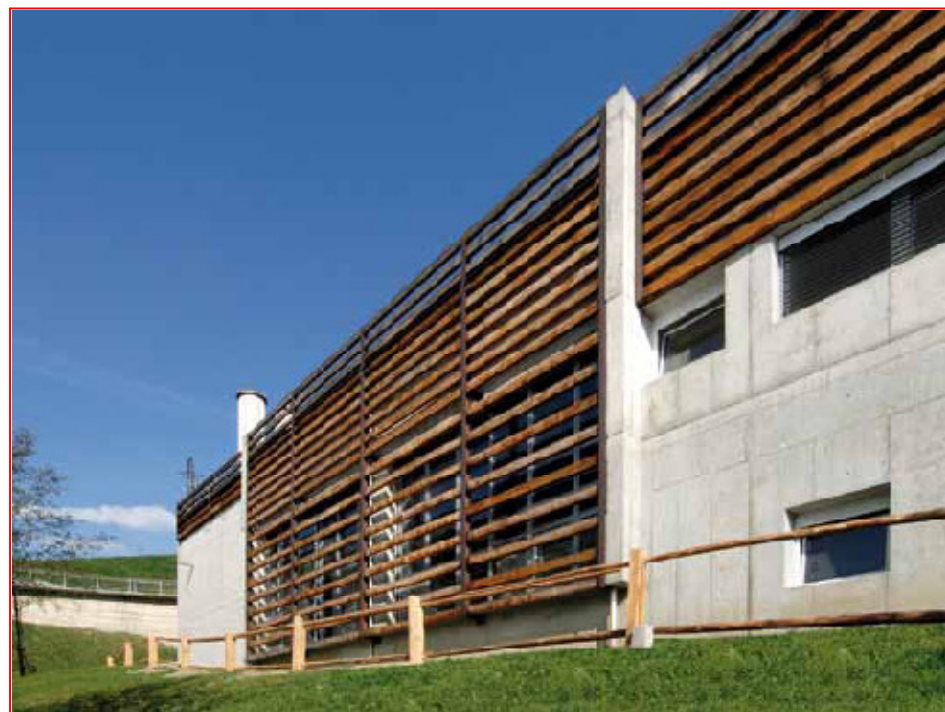
Impianto a biomasse di Lanzfons nel Comune di Chiusa (BZ)
