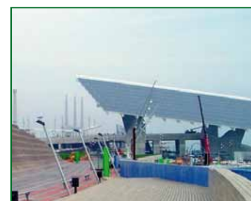
Barcellona, pannello solari in prossimità della nuova area balneare
