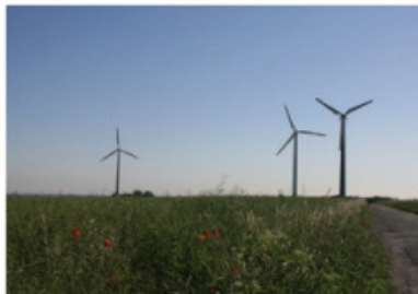
Windkraftwerke auf dem Ostenberg
