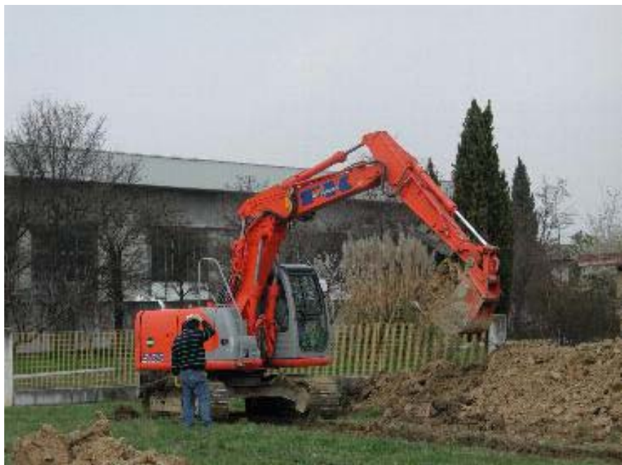
Particolare scavo “trincea”
