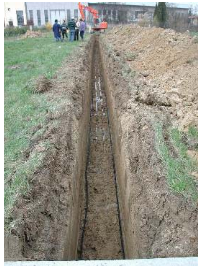
Sistema 4 tubi particolare posa tubazione su fondo
